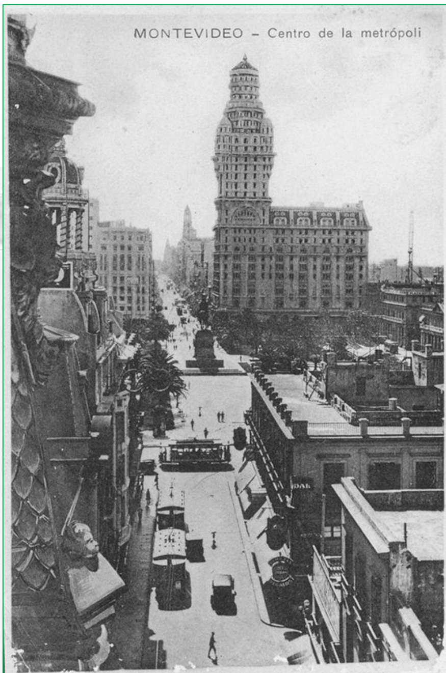
Imagen 4: Palacio Salvo en el momento de su inauguración. Ca. 1930. Palacio Salvo, Avenida 18 de Julio entre Plaza Independencia y Calle Andes, 1922-1928, Mario Palanti
