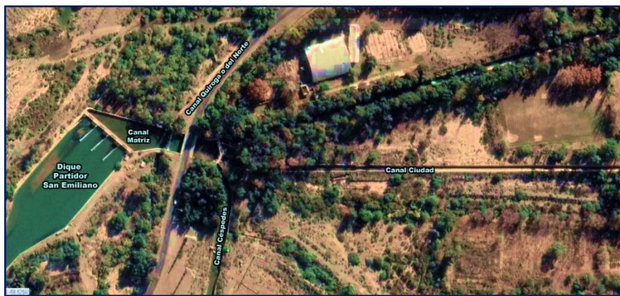
Figura 2. Dique Partidor San Emiliano y canales principales de riego de la provincia de San Juan
