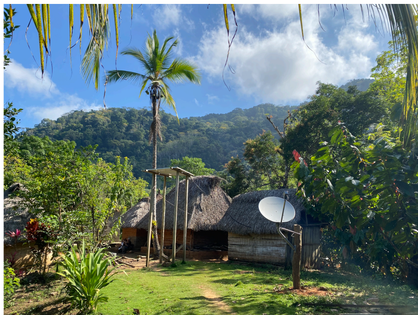
Imagen 3-11 Instalación de la infraestructura solar y de conectividad en Murunmuke
