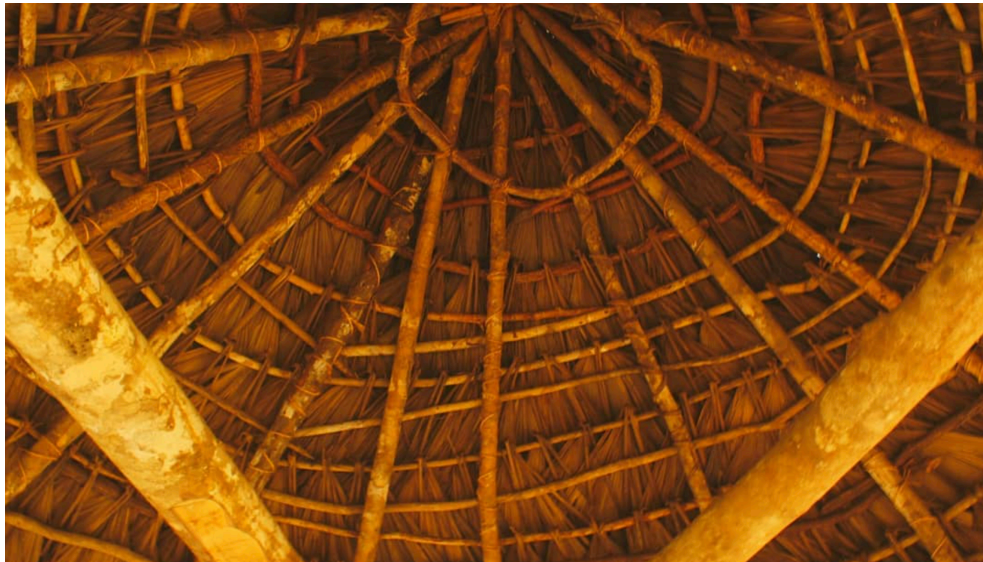
Imagen 3-8 Técnica de construcción tradicional Arhuaca
