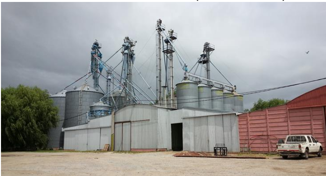
Vista de la planta de alimentos
